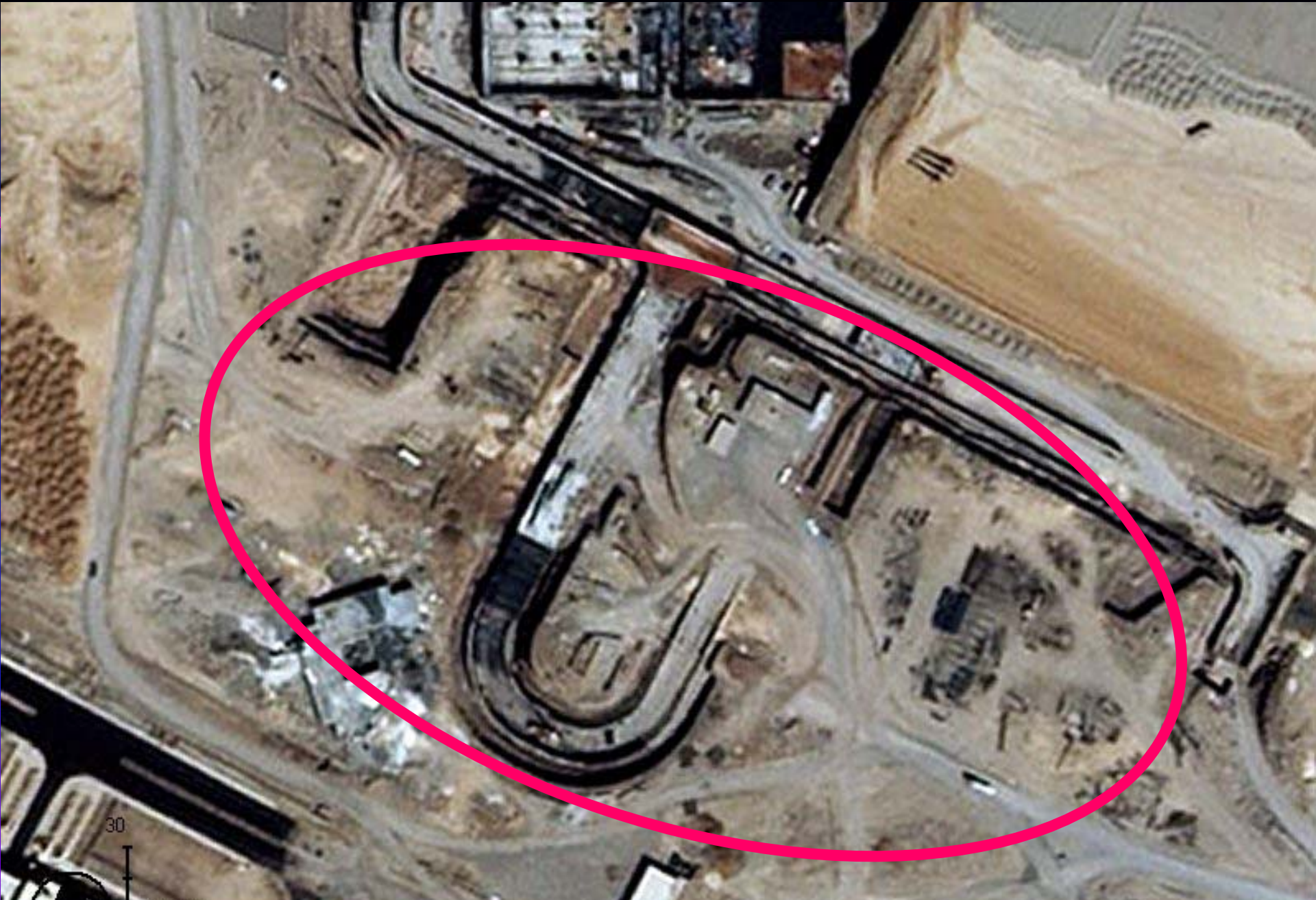
La construcción de la entrada del túnel a los edificios subterráneos.
