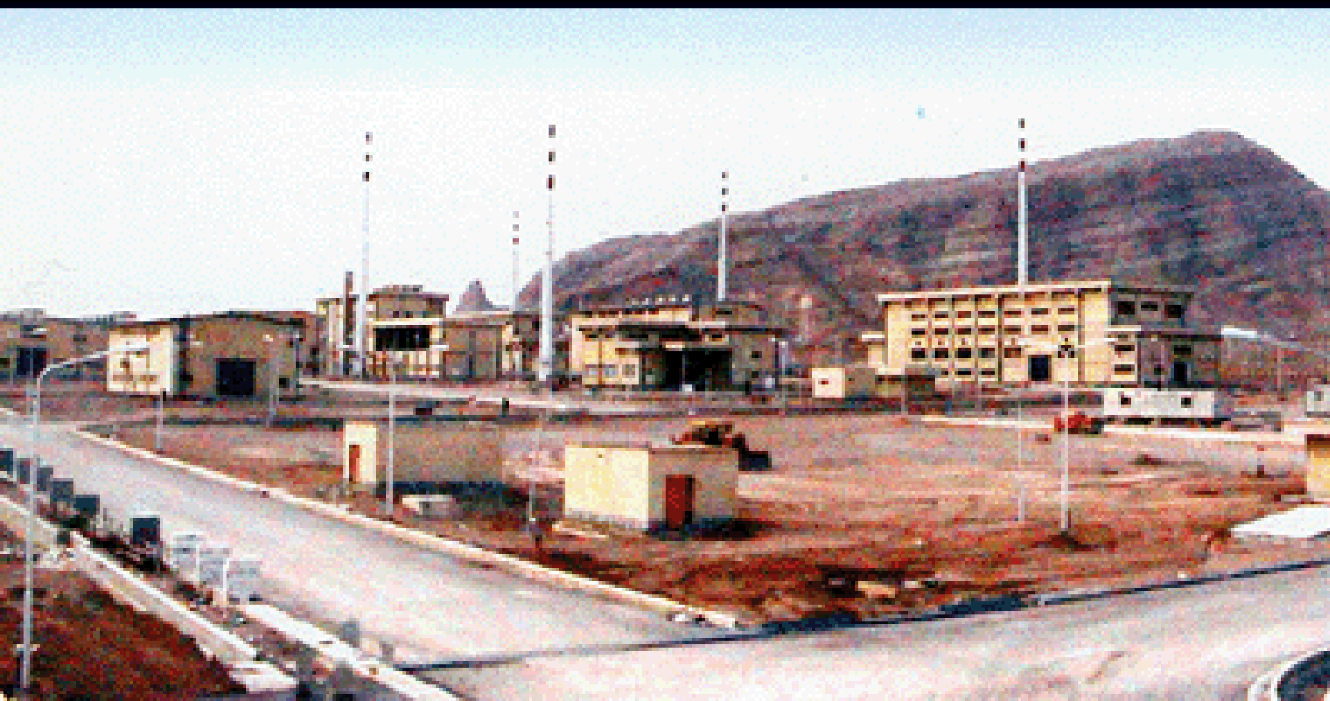
La Planta de Producción de Circonio (ZPP) de Isfahan
