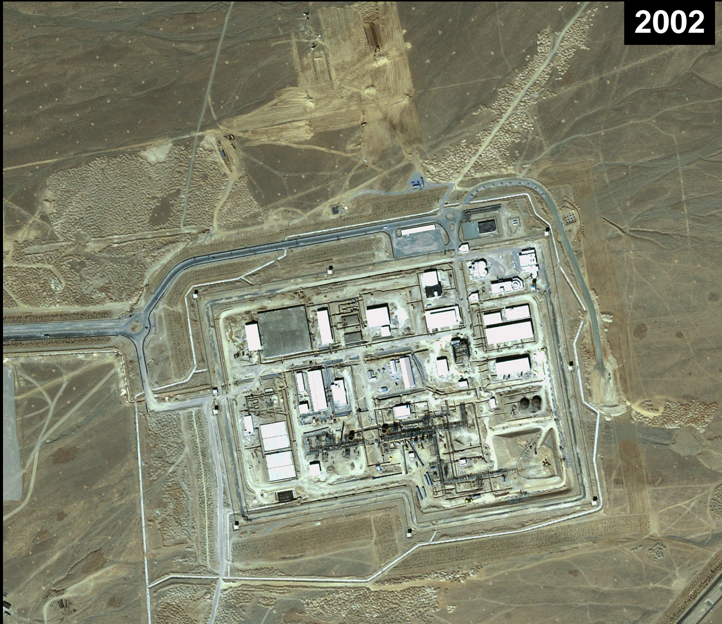
Arak: Instalación de producción de agua pesada
